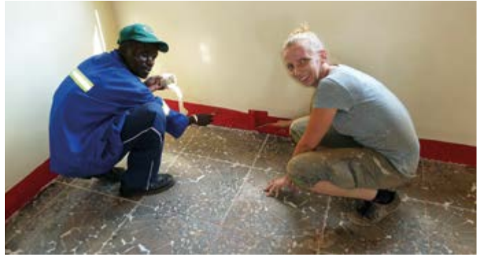
Stefanie Ruhl hilft beim Ausbau der Schlafräume mit.
