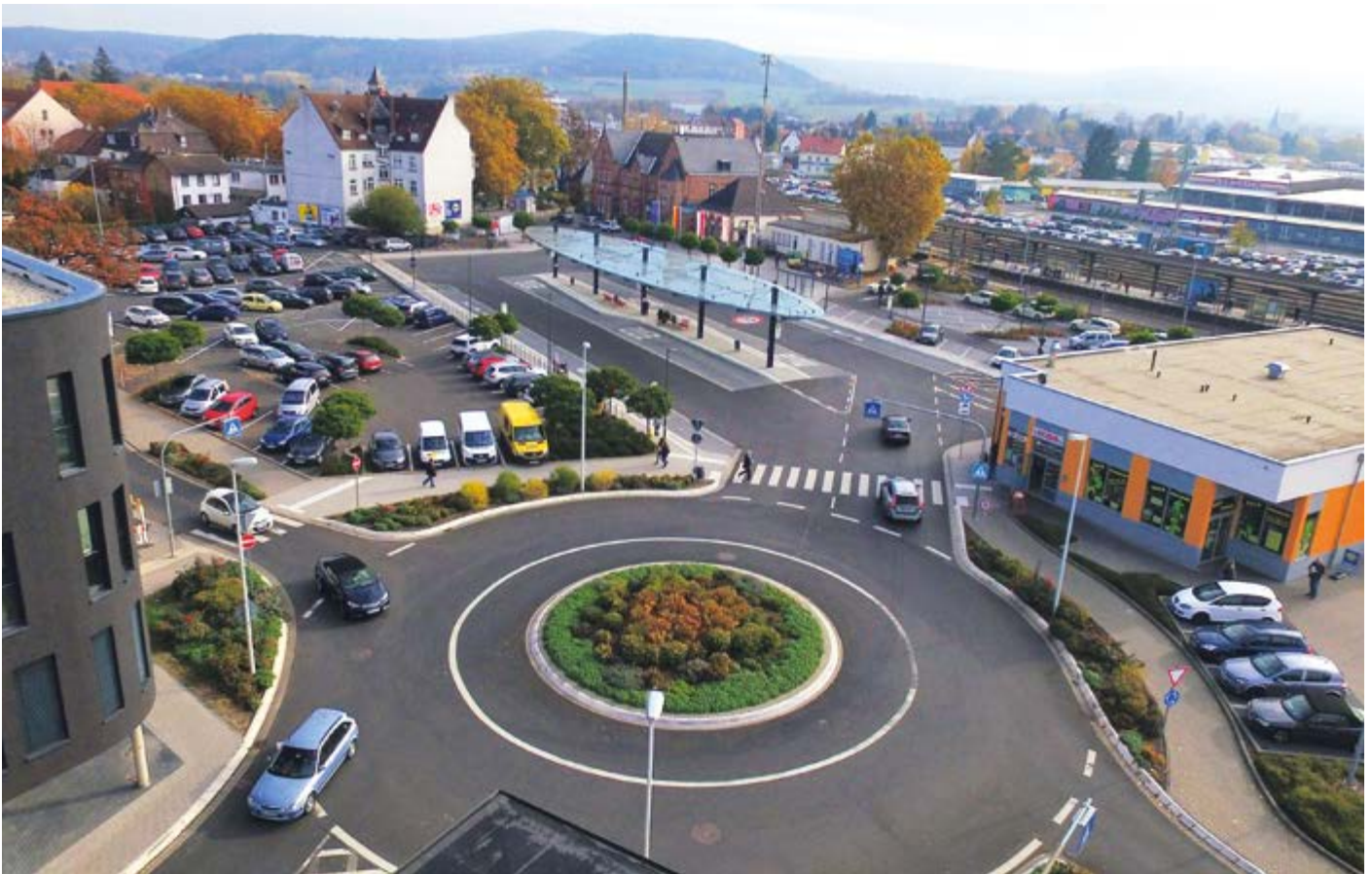
Angefangen beim Kreisel an der Hailerer Straße hat sich das Gelnhäuser Bahnhofsumfeld in den vergangenen Jahren sukzessive gewandelt. Nun ist das Gesamtprojekt abgeschlossen.
